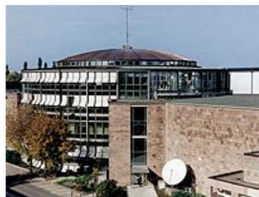
Funkhaus am Dornbusch: Der Rundbau.
